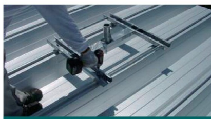
④ハゼ金具のナットをインパクトレンチで締め込み固定する。(ハゼ金具4ヶ所)
