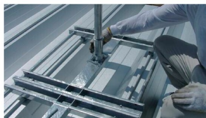
⑥支柱ベースソケット部と支柱の穴にトグルピンで貫通させて固定する。
