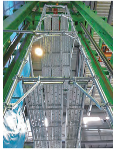
支柱強化の荷重試験
